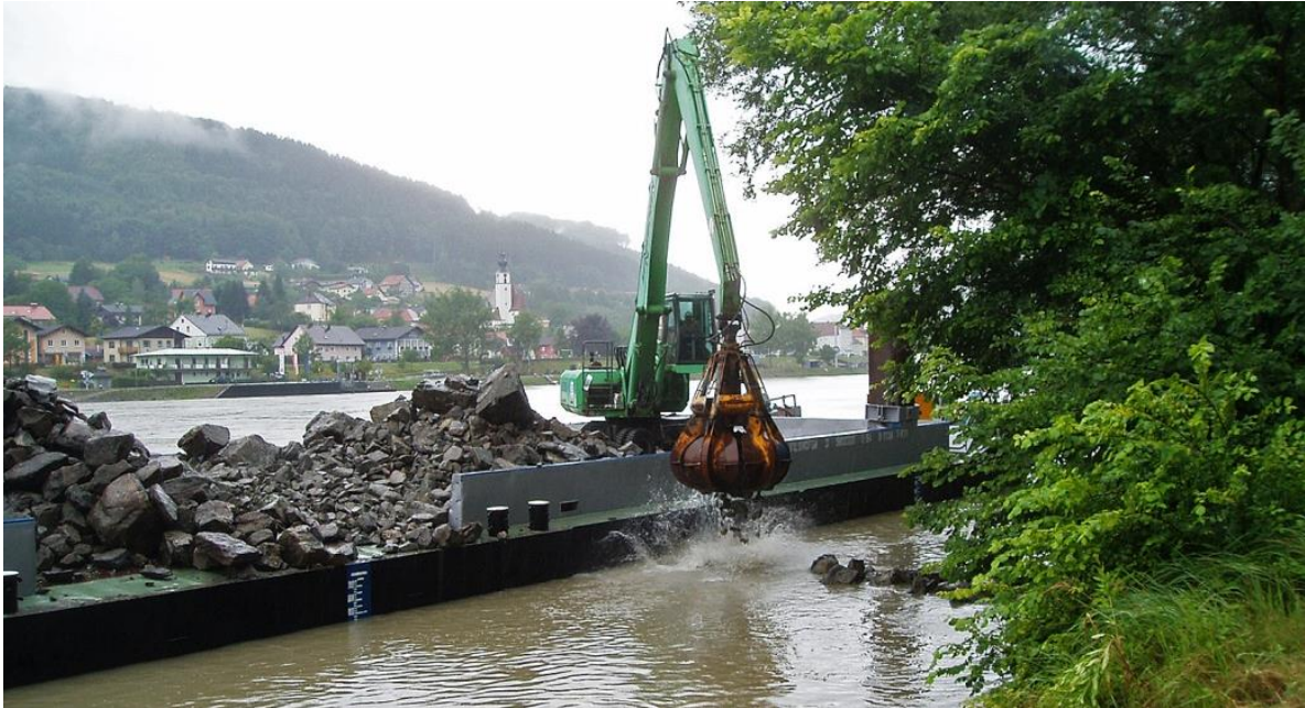
Abb. 167: Einbringen von Kurzbuhnen
