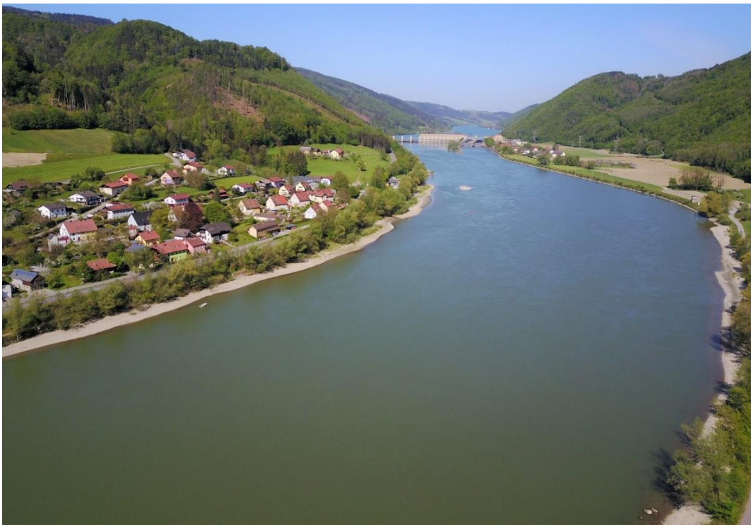
Abb. 159: Donau im Unterwasser des Kraftwerks Jochenstein
