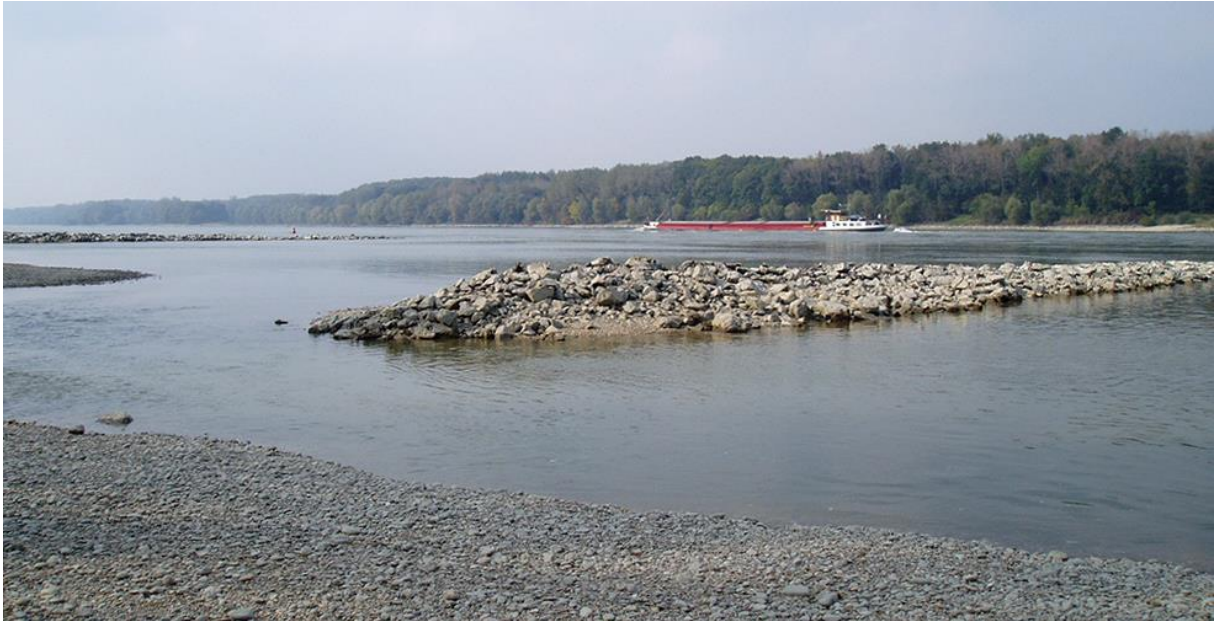
Abb. 154: Hinterströmte Buhne und dahinterliegend ungesichertes Kiesufer
