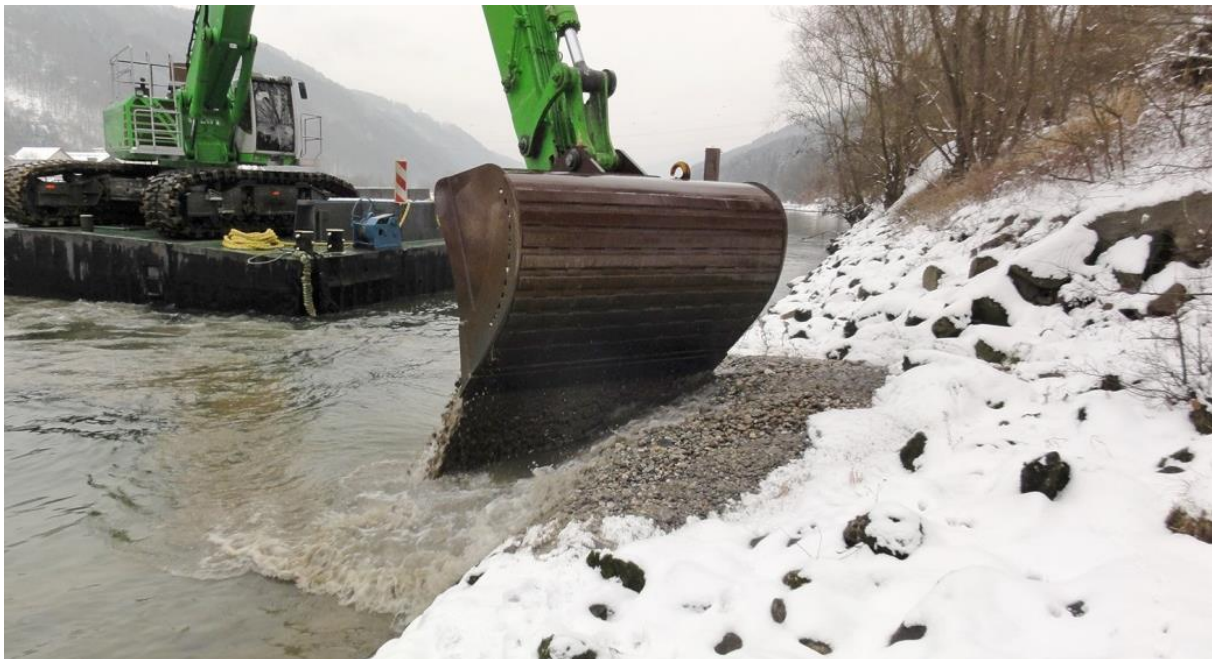
Abb. 169: Entfernen oder Überschütten von Blocksteinstrukturen Foto: TB Zauner
