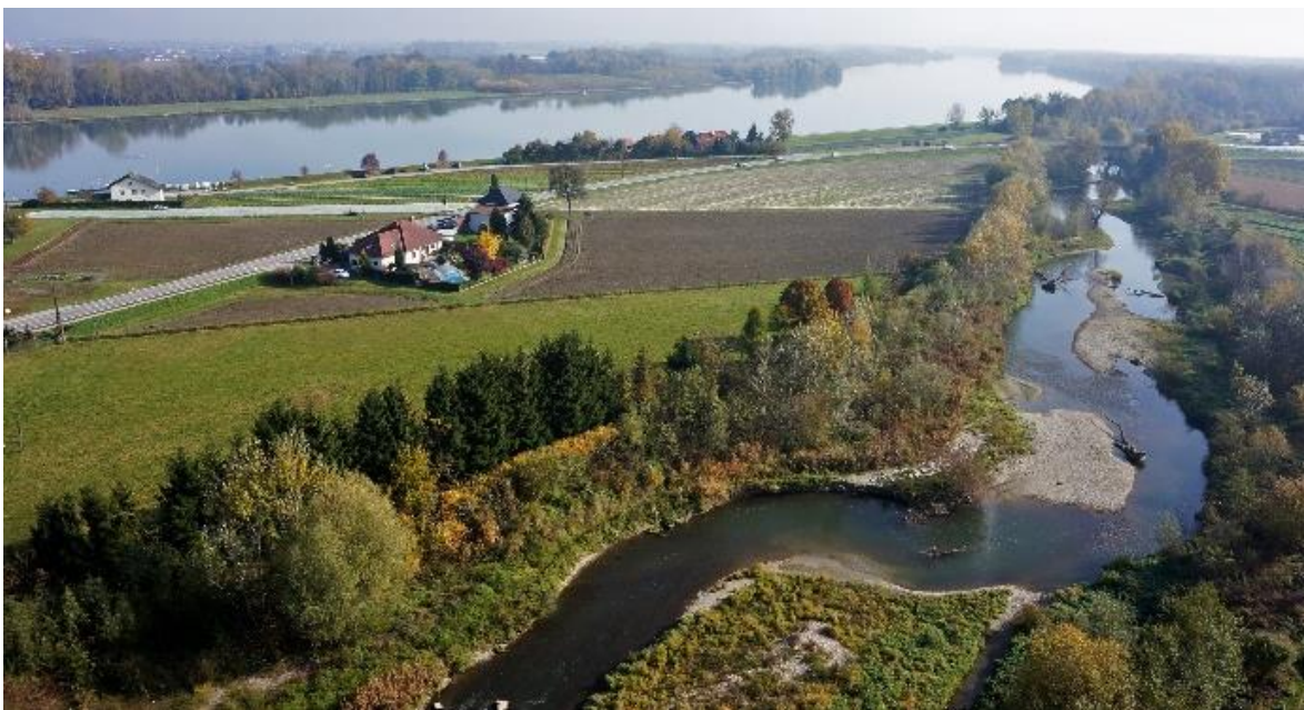
Abb. 170: Dynamischer Umgehungsbereich am Donaukraftwerk Ottensheim-Wilhering
